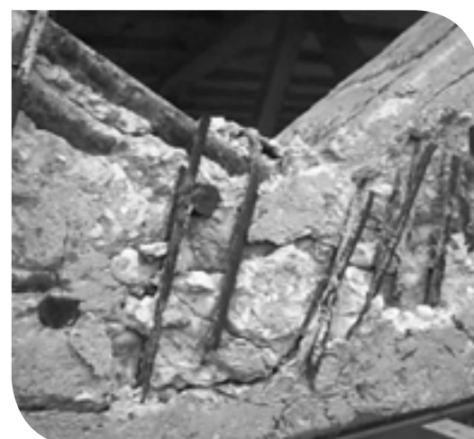
Tirante diagonale di travatura reticolare Guy diagonal truss
